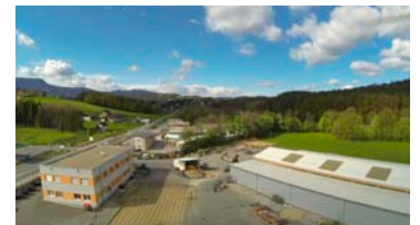
Rechts neben dem Firmengebäude wird das neue Zentrum für Regeneration gebaut.
